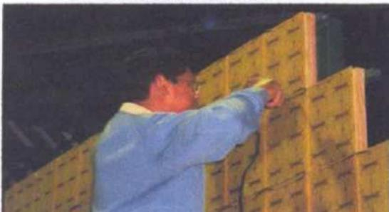
Une antenne «rectenna», composée de radiopiles (modules rectangulaires)
